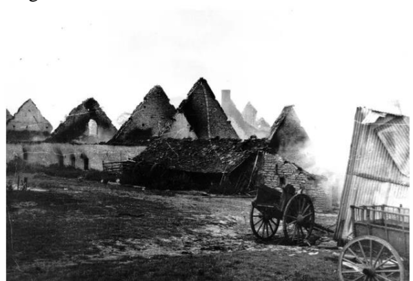
La désolation dans la cour de la ferme après l'incendie © archives Elisabeth Jamet
